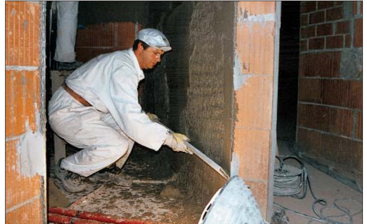
Die Arbeiten am Haidhauser Neubau laufen wie geplant: hier Anfang Mai die Maurer beim Verputzen der Innenwände. Foto: cws
