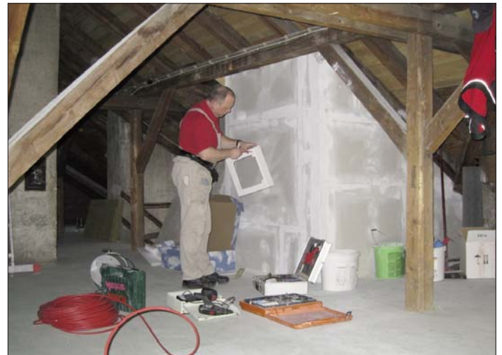
Die Dämmung der Speicher erfordert weitere Arbeiten wie hier den Einbau der Steuerung eines Rauchabzugfensters Fotos: cws
