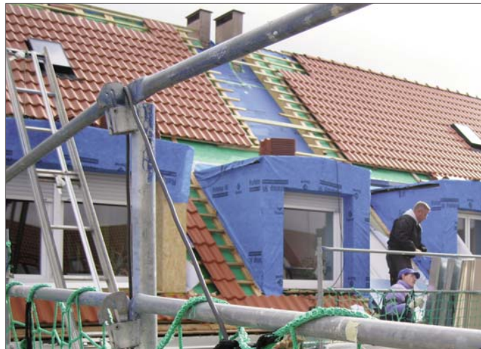
Ideal für die Sanierung von Altbauten mit bewohntem Dachgeschoss: eine Vollsparrendämmung aus Schaumkunststoff Foto: cws
