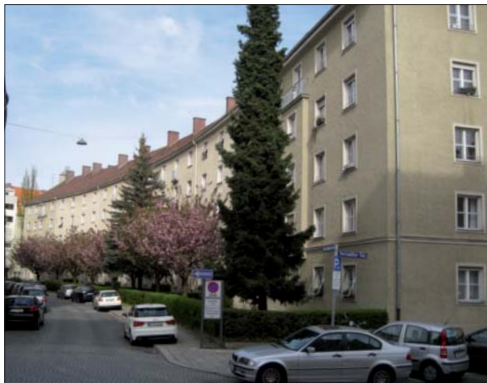
Die Häuser Hackländerstraße 1, 3, 5, 7 und Versailler Straße 17 F.: cws
