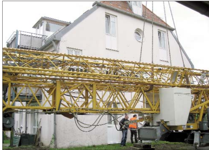
Am Haus Wasserburger Straße 7c-d wird der Kran aufgestellt für die Dacharbeiten und das Aufsetzen vorgefertigter neuer Gauben E.: cws
